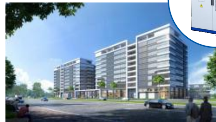
智光数字能源技术产业园 (增城区)
