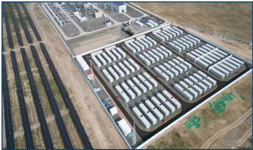
华能青海海南州高压储能电站 150MW/600MWh
