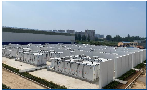
华电集团全球首个100MW级联 高压液冷储能电站
