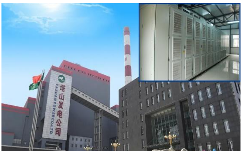
火电厂600MW机组电动给水泵变频改造项目
