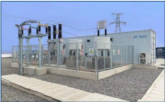
35kV变电所SVC升级改造工程
