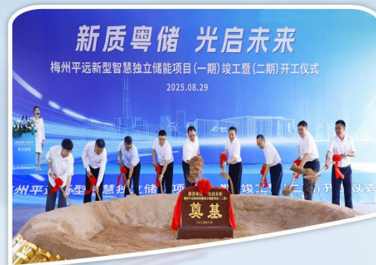
梅州平远 (二期)智慧储能电站项目开工
